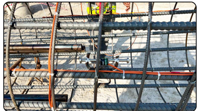
[파일 재하시험용 케이스에 1240 설치 사진]
