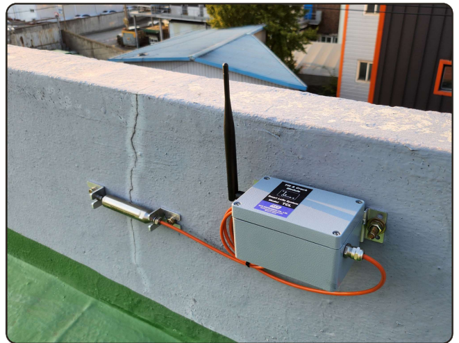
[TCL 벽체 설치 / 경사계는 모듈 내부에 장착됨]
