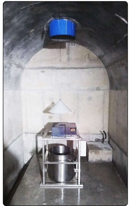
[담 설치 사진]
